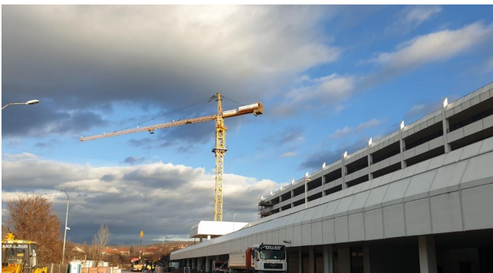
Слика бр. 23. Детаљ изградње новог ЗЦ „Топлица” у Прокупљу, која је у току.
